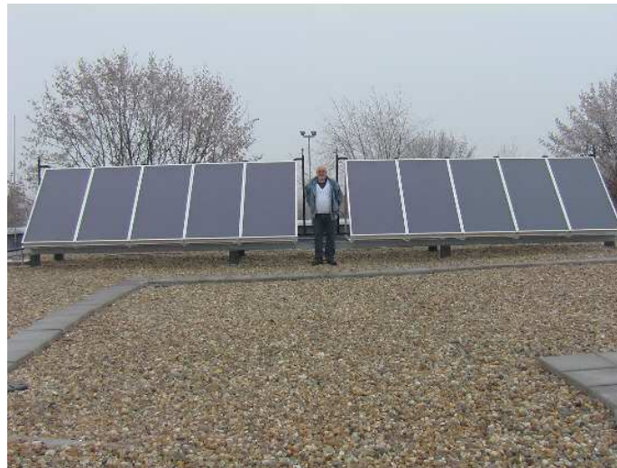
3. ábra. 20 m 2 síkkollektor elhelyezése a lapostető D-i részén
