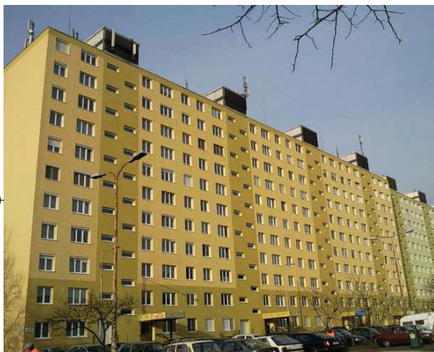
3. ábra – Az A+ besorolású, 256 lakásos társasház (Bp. XIII., Hun u. 1–15.) talajvíz hőforrású hőszivattyús rendszere és üzemeltetése 2009. májustól (Forrás: GEO-NRG Kft.)
